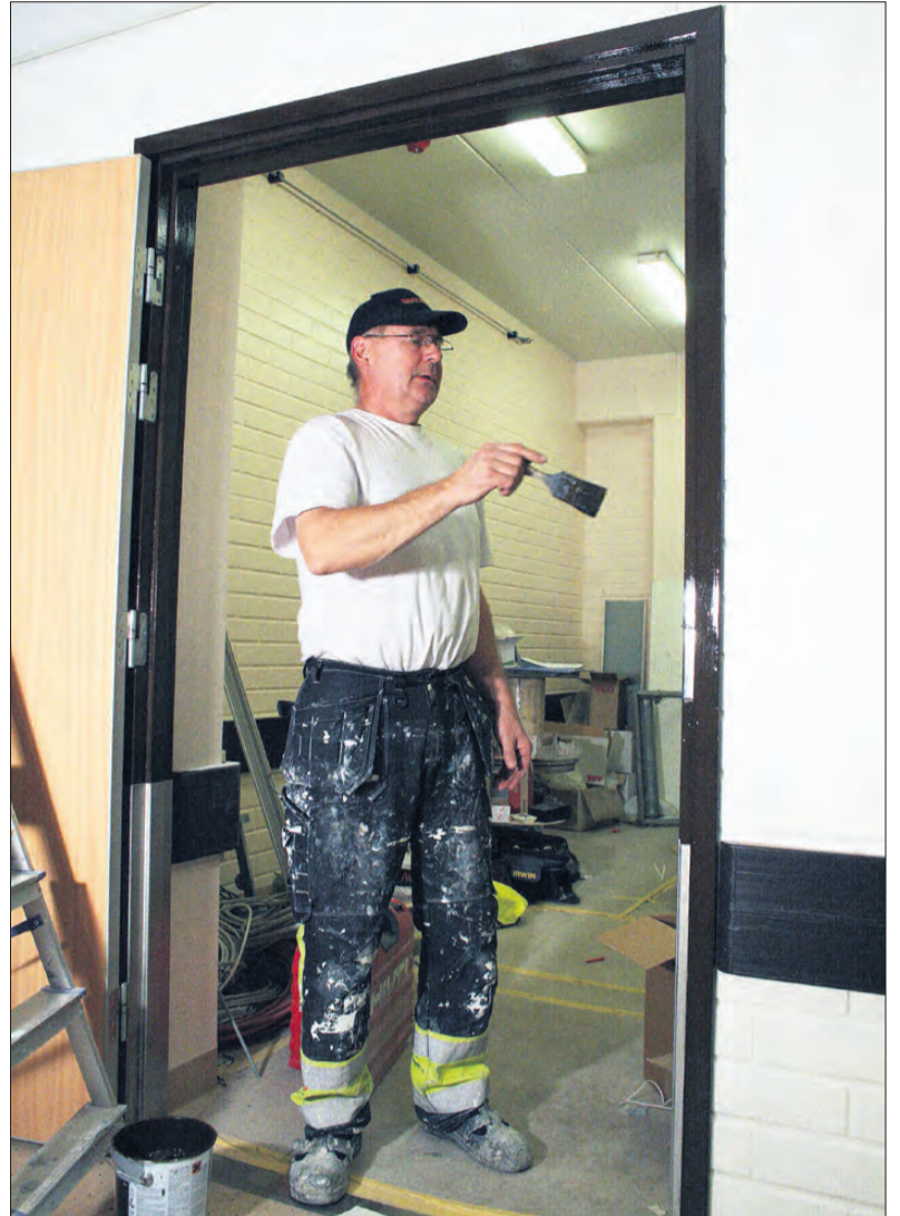
Sten Källskog målar dörrkarmarna. Den mörka färgen ska hjälpa dem som ser dåligt att hitta fram till rätt ställe. Källskog arbetar för Vasa-företaget WBR.
