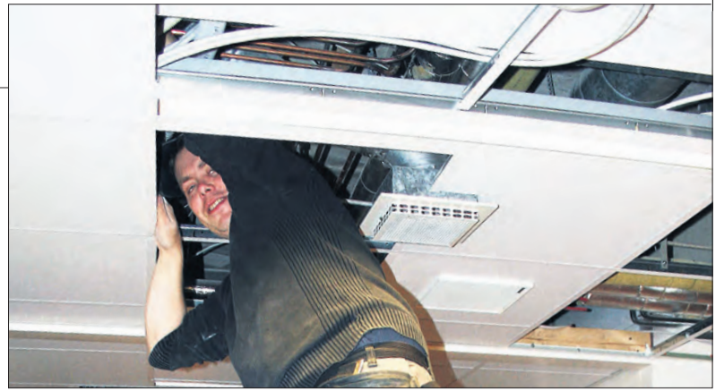
Mårten Vikström är en av de vvs-montörer som arbetar med ventilationen på bäddavdelningen i Oravais. Han är anställd av Vörå Rör.
